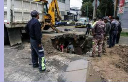
“Lo que provoca el hundimiento de la ciudad es la sobre-explotación de agua y el quebrantamiento de la arcilla, que al ocasionar presión en las tuberías hace vacíos que con el paso del tiempo se convierten en socavones y daños en la estructura de unidades habitacionales”, detalló Miguel Castillo Cruz, experto en mecánica de suelos y vías terrestres de la Escuela Superior de Ingeniería y Arquitectura (ESIA) del Instituto Politécnico Nacional (IPN).
