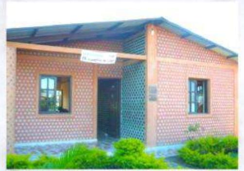
Algunas de sus propiedades son reutilizables desechos invariables y de reciclar , es un excelente aislante térmico y acústico ,antisismico debido a su bajo peso y reemplaza materiales de construcción altamente contaminante .
